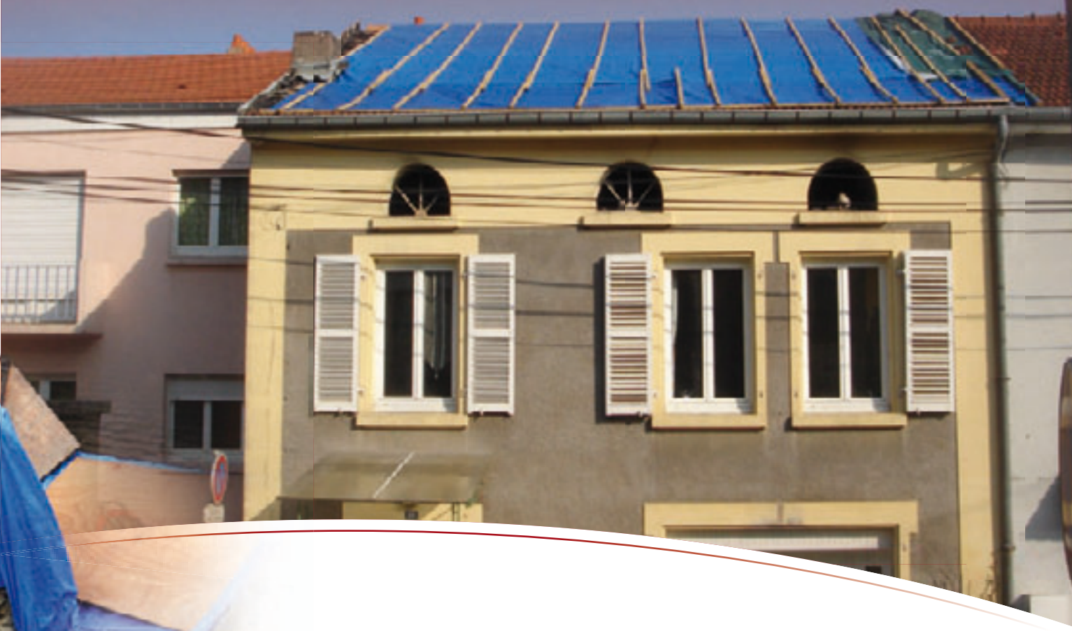
Immeuble après bâchage
