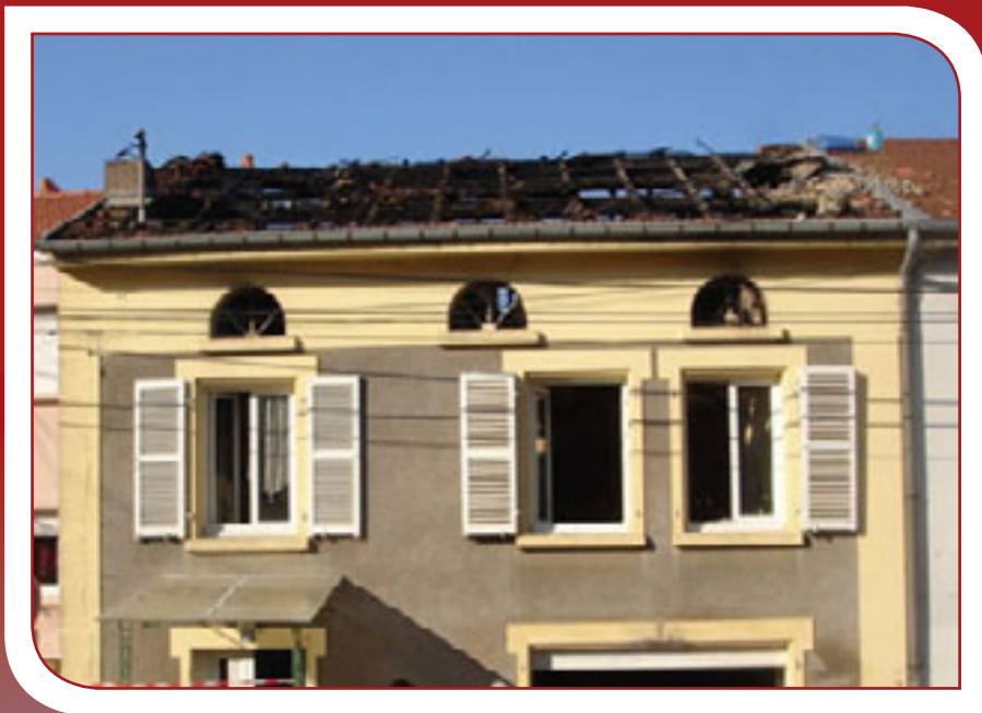
Immeuble avant bâchage
