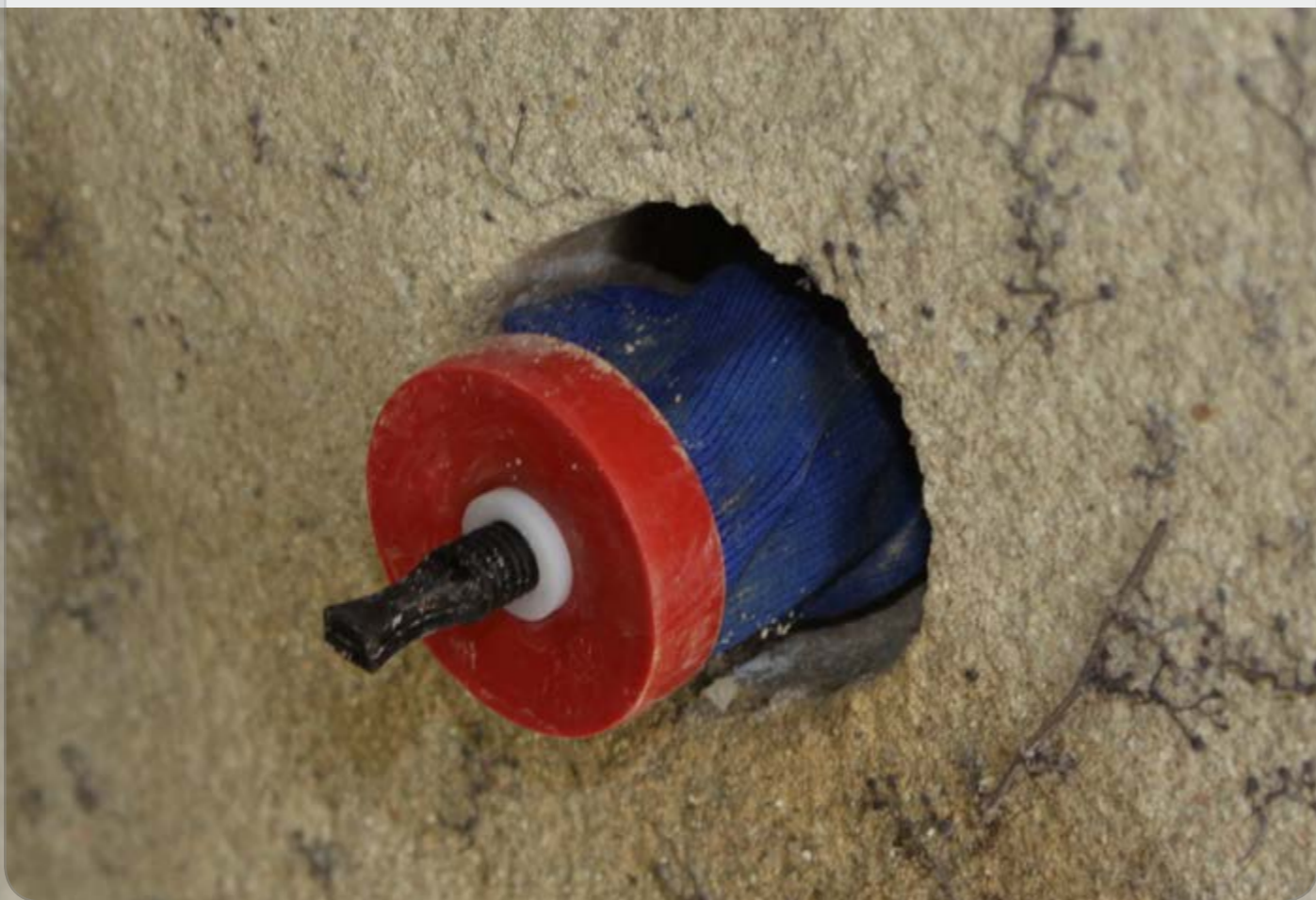
Création de chaînage (procédé RENFORTEC)
