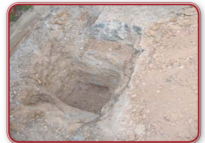
Fondation semi-profonde (puit)
