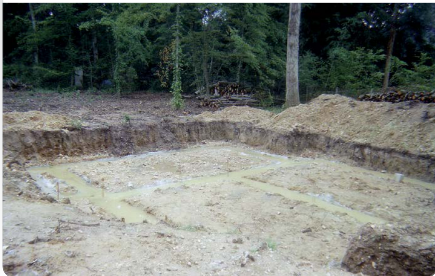
Tranchées inondées pour les fondations d'une maison
