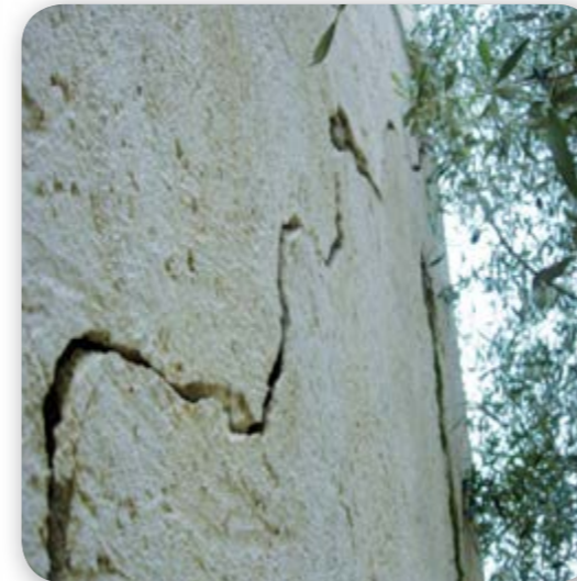
Fissure évolutive à 45° avec désaffleurement
