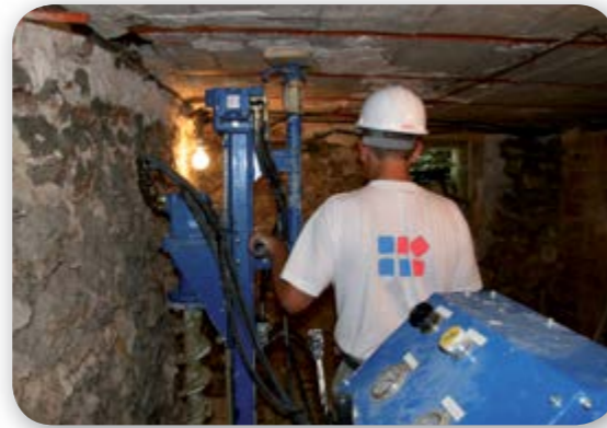
Forage pour l'installation d'un micropieu
