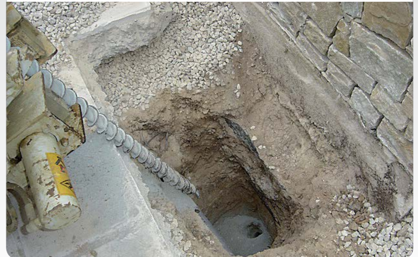
Fouille de reconnaissance de fondation
