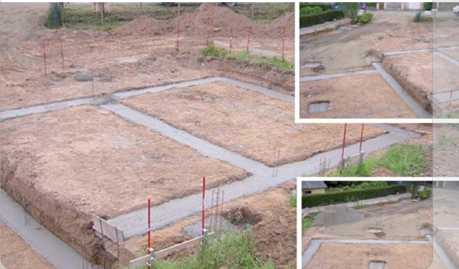
Réalisation des fondations d'un pavillon
