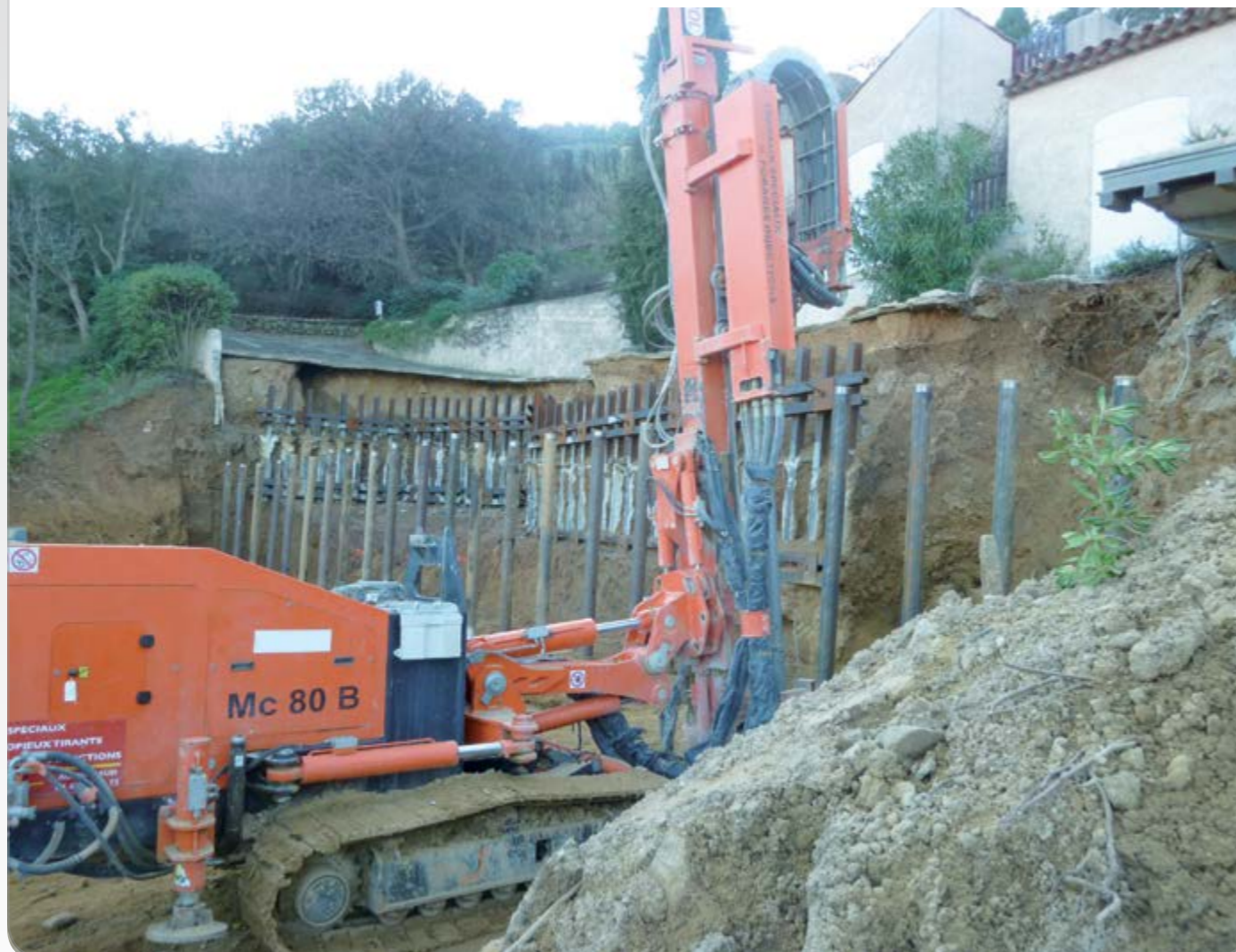
Création d'une paroi de soutènement de type berlinoise suite à un glissement de terrain
