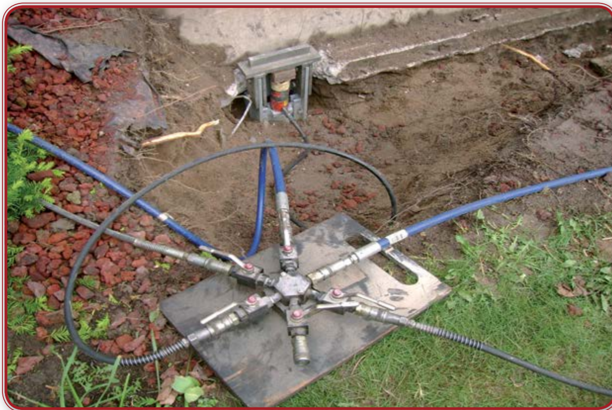
Vérinage d'une structure
