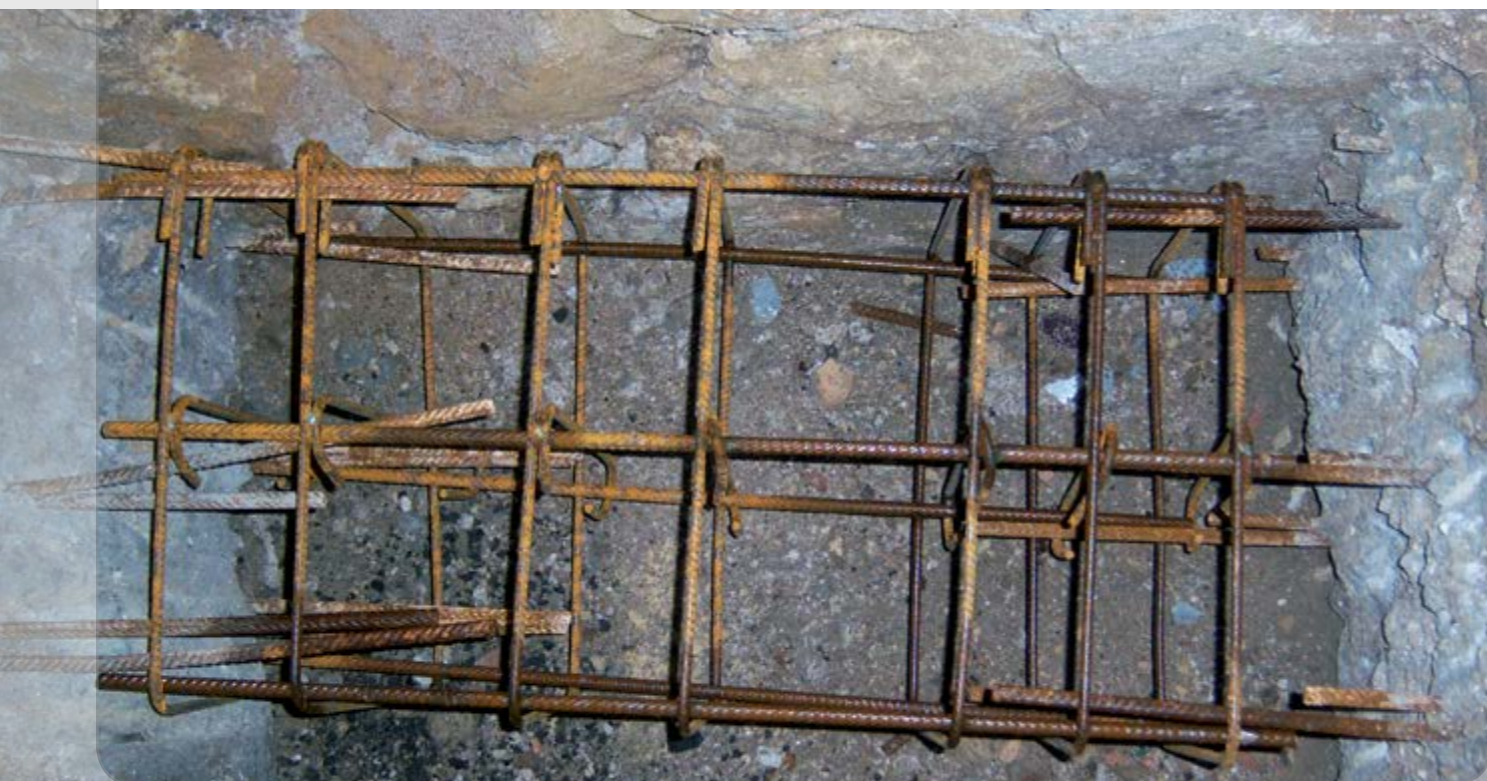
Mise en place d'une longrine de rigidification
